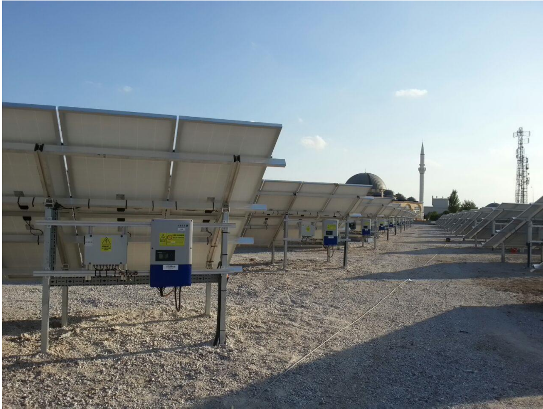
Ein Megawatt für Konya: In einer stark dezentralen Auslegung werden Powador 20.0 TL3 von KACO new energy verwendet. Bild: © KACO new energy GmbH
